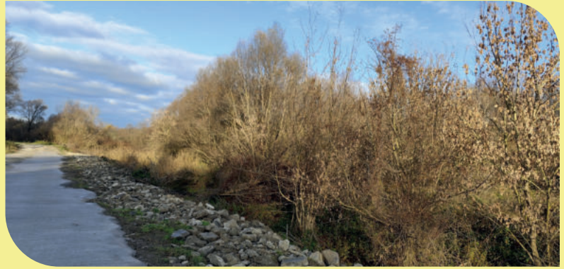
4. kép: A Szürkei töltőbukó helyreállított kövezése
