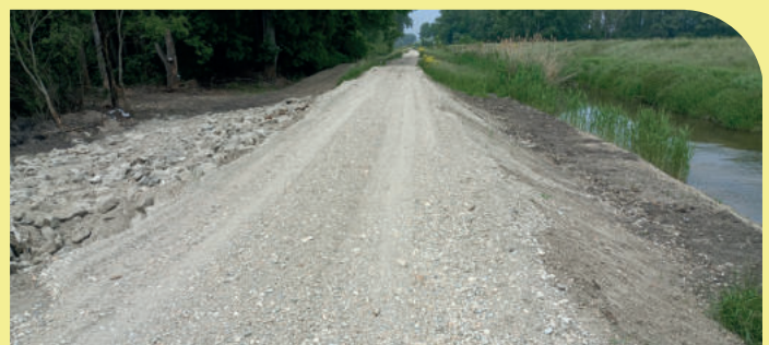
3. kép: A helyreállított megnyitási hely balra a kövezett utófenékkal
