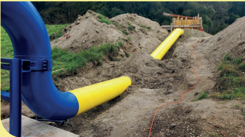
5. kép: Az új nyomócső a megbontott védműben
