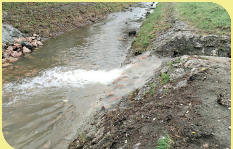
7. kép: : Helyreállított burkolat az Által-éren
