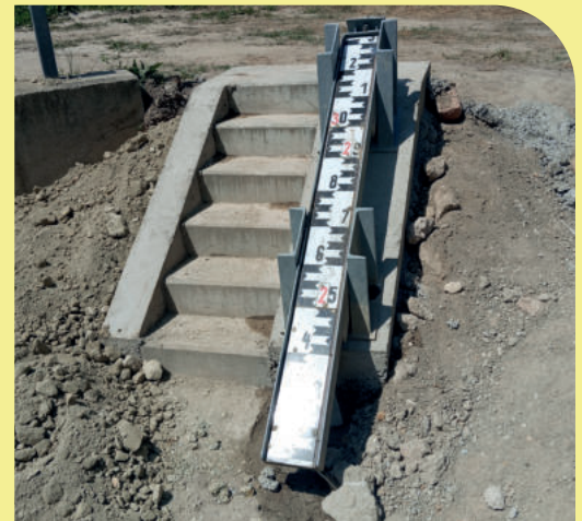
6. kép: Új középvízi vízmérce-tag a Rendei zsilipnél
