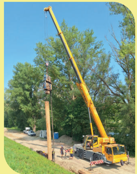
1. kép: Szádfalverés 2025. június 11-én
