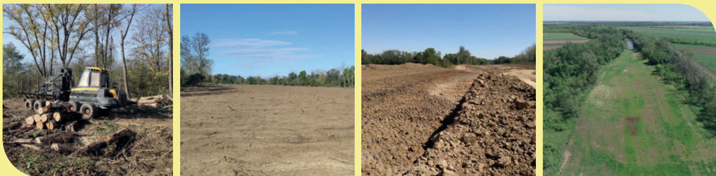
1. ábra: árapasztó vápa kialakításának folyamata
