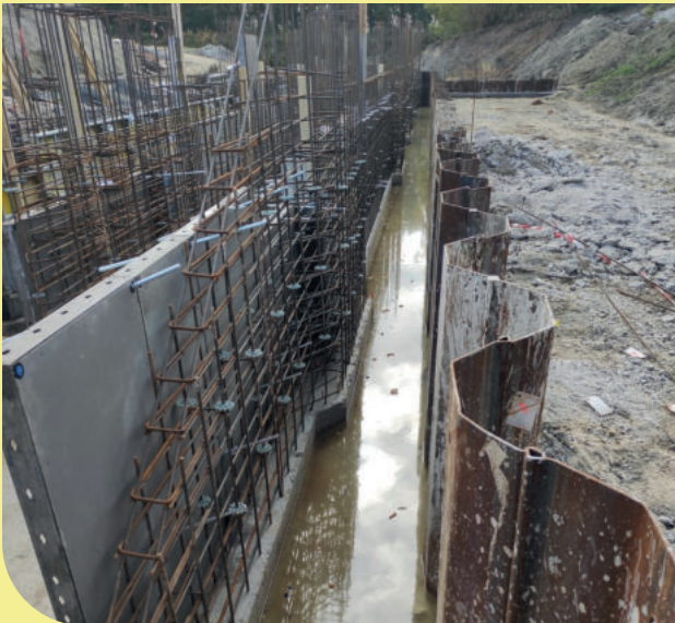
3. ábra: Új Mosonszentjánosi zsilip szerkezetépítése
