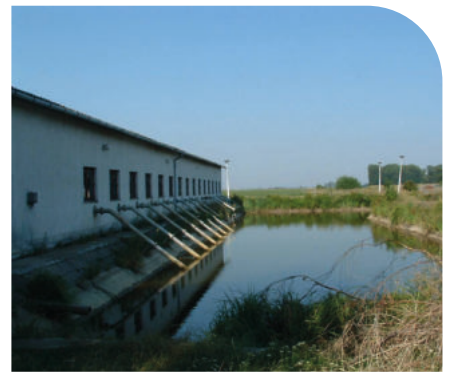
AC. nyomócsöves felszín alatti öntözőtelep, Zsebeháza
