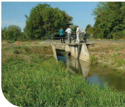
Billenőtáblás elzáró szerkezetű, olajhidraulikus, kötéletes mozgatású műtárgy, Keszeg-ér duzzasztó, Magyarkeresztúr
