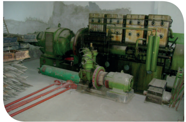
11. kép: A harckocsi motorral hajtott szivattyú kiváltására beszerzett Ganz generátor és annak Jendrassik diesel meghajtó motorja
