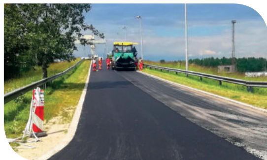
Dunakiliti duzzasztómű, aszfaltozás
