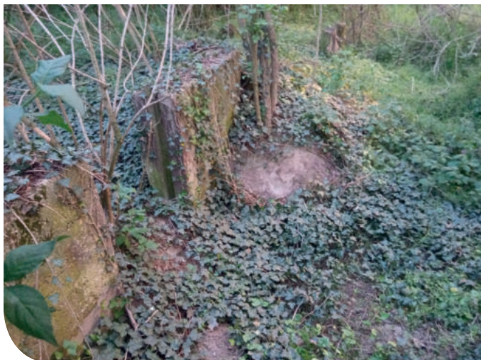
2. ábra: Irányfordító műtárgy maradványai az öntözőcsatornán
