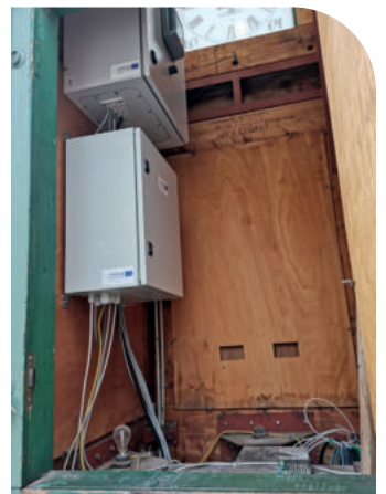
4. kép: Vízrajzi távmérő eszközök műszekrényei az óratoronyban
