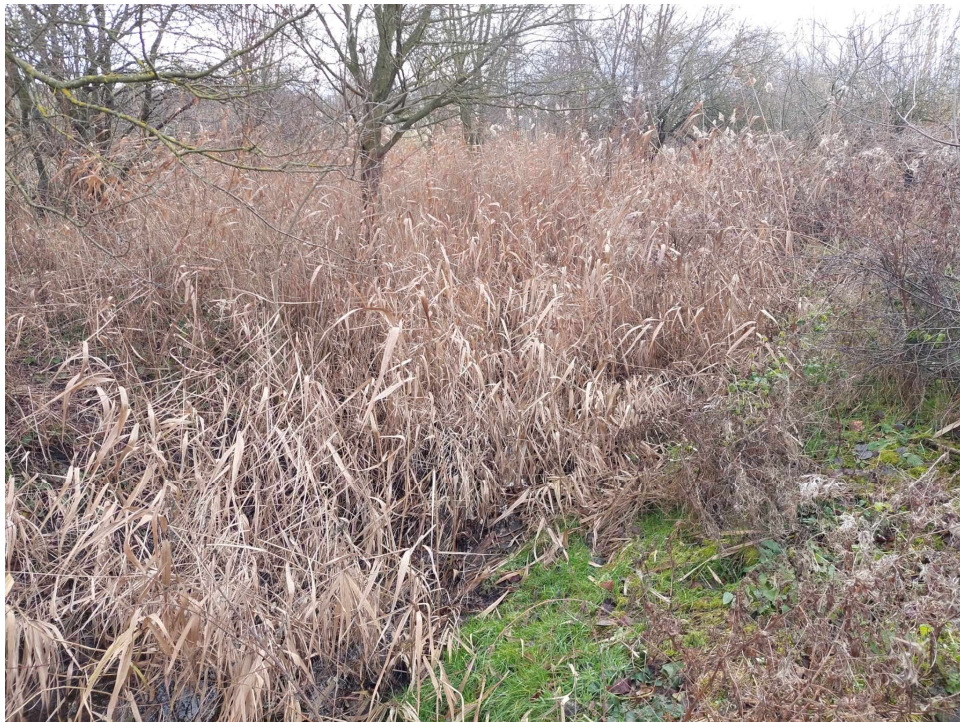
20.kép: Teljesen benőtt meder nagy mértékű visszaduzzasztást és feliszapolódást okoz. 0+750 szelvény körül, folyásiránnyal szemben fényképezve.
