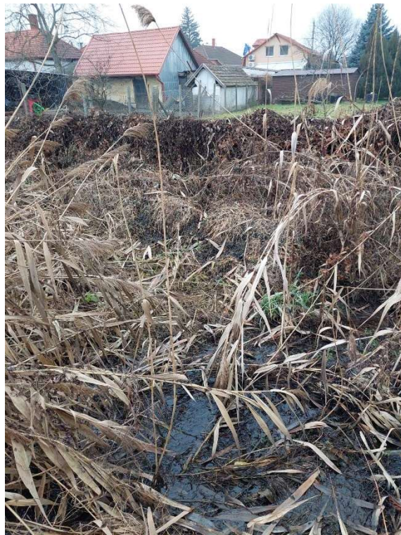
21-22.kép: Mederszakasz vége, a zárt szakasz kitorkolása. A teljesen benőtt szakaszon a mederfenéktől mért 1,0 méteres a visszaduzzasztással és fél méteres feliszapolódással.
