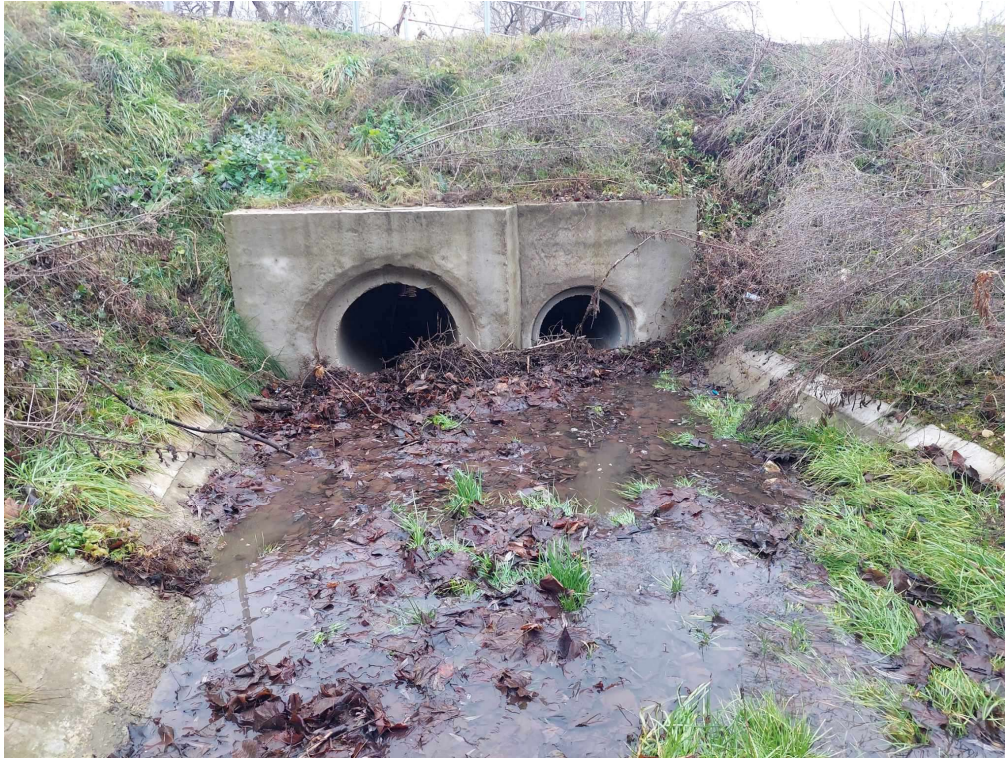
3.kép: Által-ér völgyi kerékpárút alatti dupla átereszt felvízi oldala.
