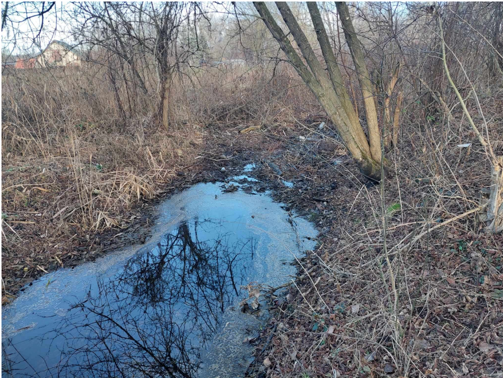
15.kép: Visszaduzzasztást okozó uszadék feltorlódás. A meder környezete benőve cserjével. Folyásiránnyal szemben fényképezve.
