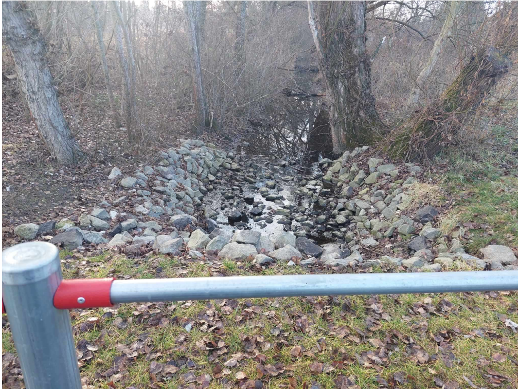
14.kép: Szakasz elején lévő átereszt felvízi oldali kőszórása a keresztező kerékpárút padkájáról fényképezve. Háttérben két visszaduzzasztást okozó uszadék feltorlódás.
