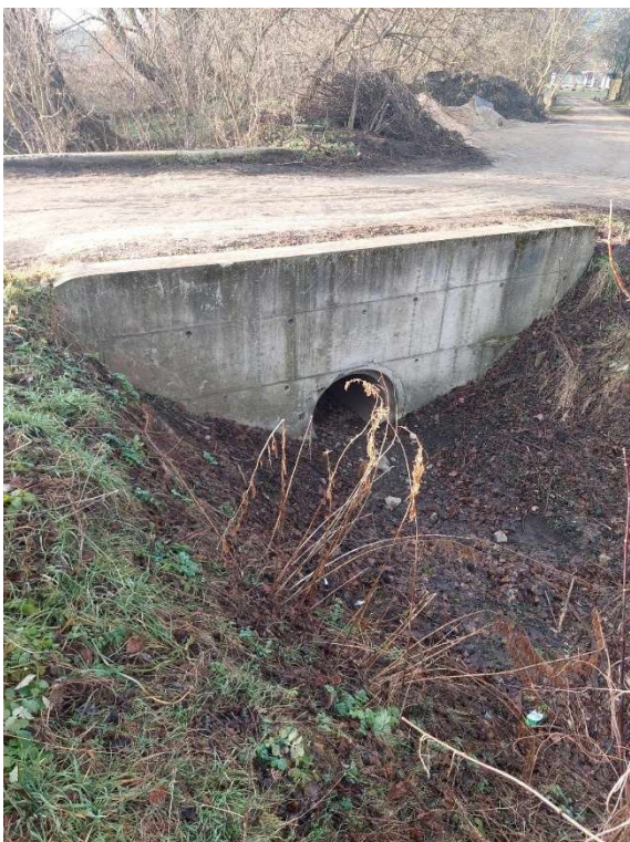
8.kép: D 800 csőáteresz a 7156 hrsz-út alatt felvízi oldal.
