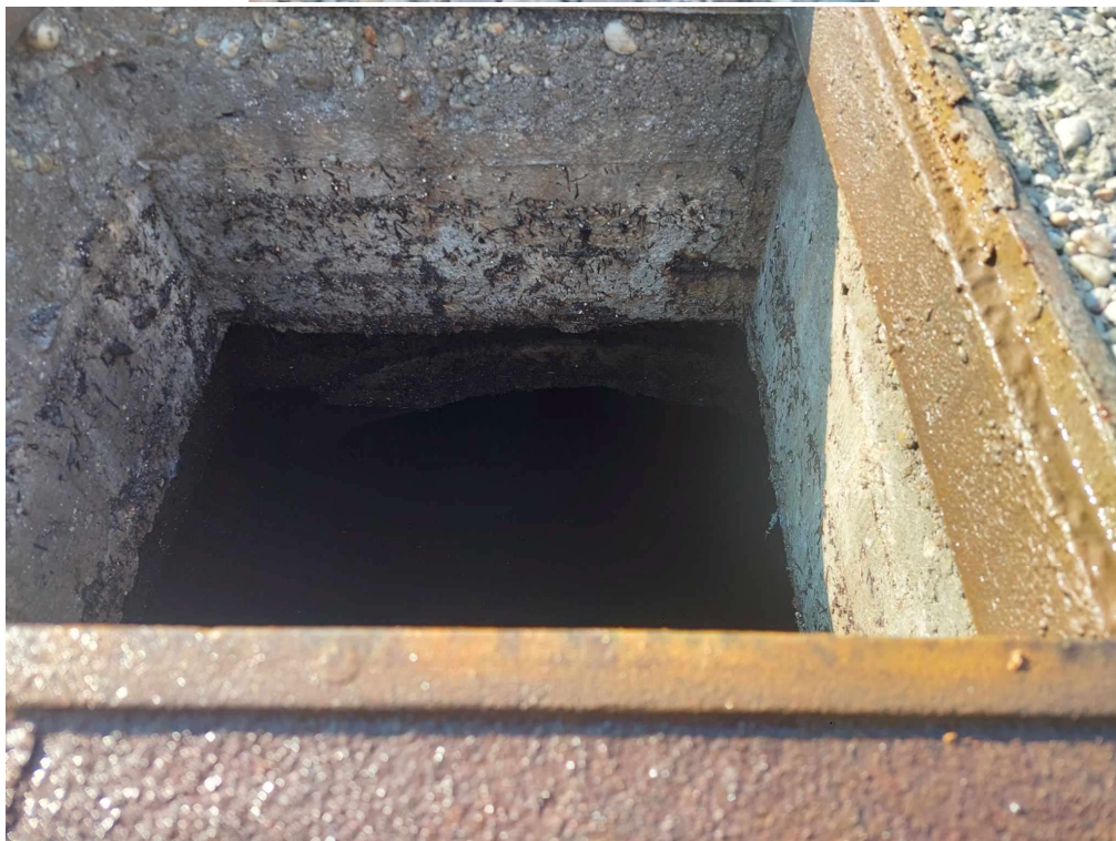
23-24.kép: Dankó utcai iránytörő akna. 1,0 méteres visszaduzzasztással és 0,5 méteres iszapréteggel.
